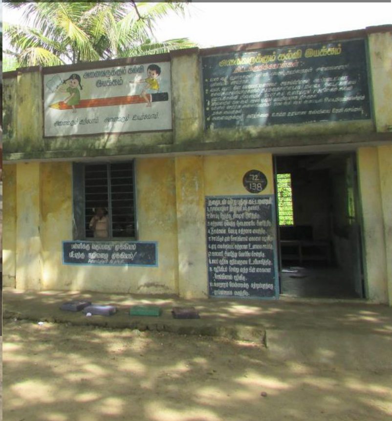
EN DÅLIGT UNDERHÅLLEN SKOLA
